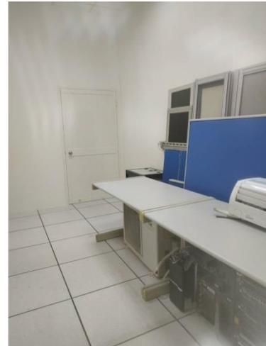
1. 寶山核心機房大門採用傳統的鋁門以及喇巴鎖，並納入機房環控監測系統。
