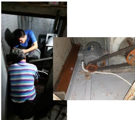
更換馬達及線路(112/9/7) 漆防水漆(112/9/8)
