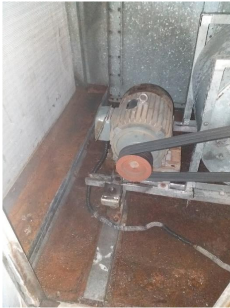
1F 東北空調箱箱底破裂漏水
