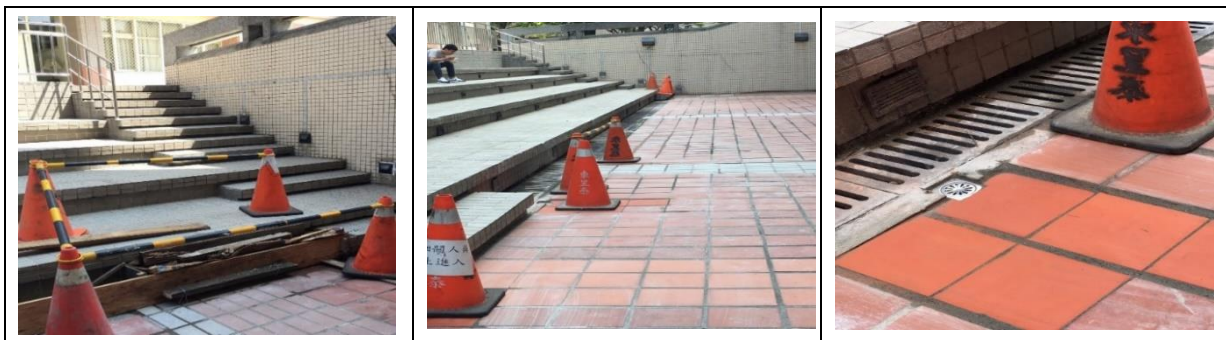
(11) 電腦教室門口左側牆壁滲水處理
