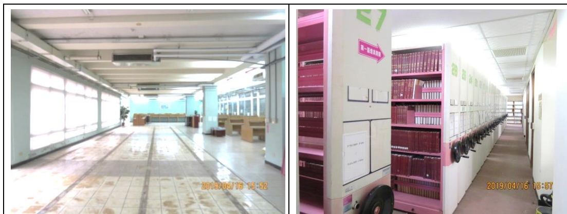
(5) 寶山分館施工照片：
