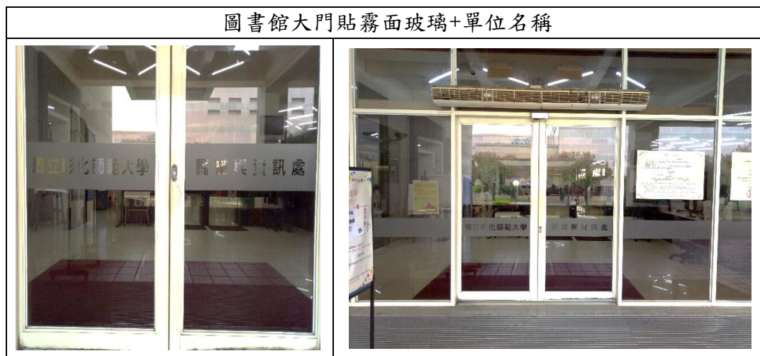
圖二 大門玻璃重新製作貼霧面玻璃
